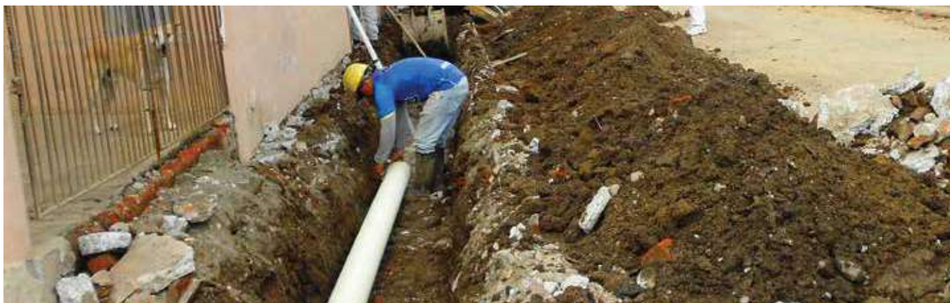
GOBIERNO MUNICIPAL DE MILAGRO Construcción de Sistema de Alcantarillado Sanitario
