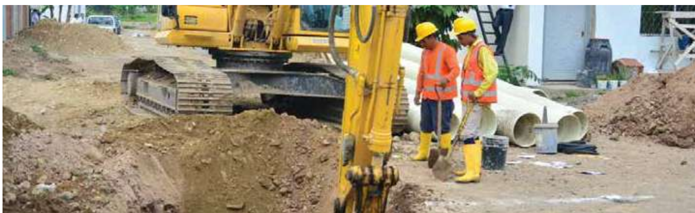
GOBIERNO MUNICIPAL DE YAGUACHI Alcantarillado Virgen de Fátima
