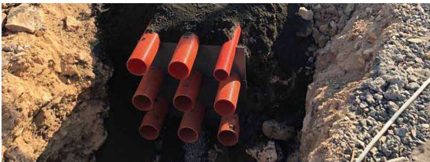
GOBIERNO MUNICIPAL DE YAGUACHI Parque Industrial de Acopio y Distribución (PIADY)
